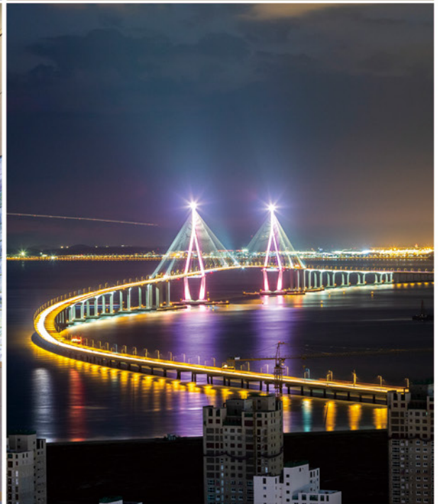
시민편의 중심 국제도시 기반시설 조성
